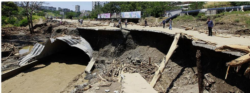
Программа российского телевидения «Погода 24» приводит оценки грузинских экспертов, которые убеждены, что виной всему недавно построенный подземный коллектор. Часть реки Вере заключили в трубу 5 лет назад. Она мешала строительству автомобильной развязки. Согласно расчетам, пропускная способность коллектора составляет 400 кубометров воды в секунду. Но этого оказалось явно недостаточно.
