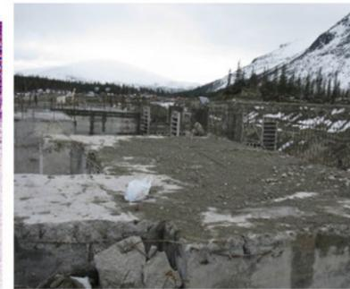
♦ Рис. 3. Георадарное зондирование по стенкам и кровле бетонных фундаментов под мельницы.
