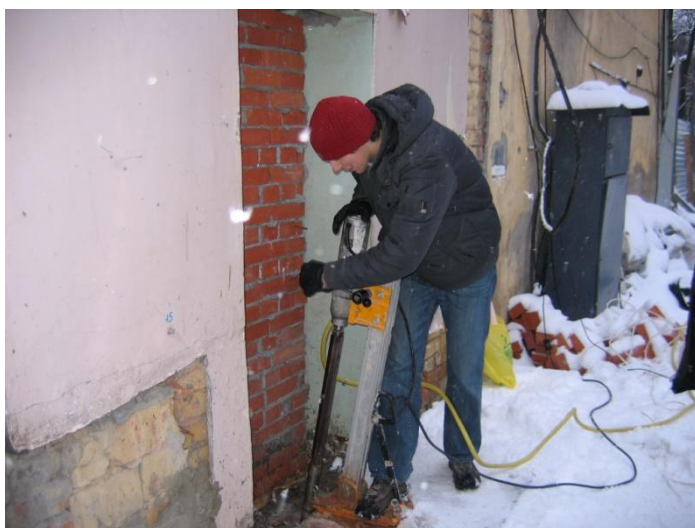
Бурение скважин и шпуров
